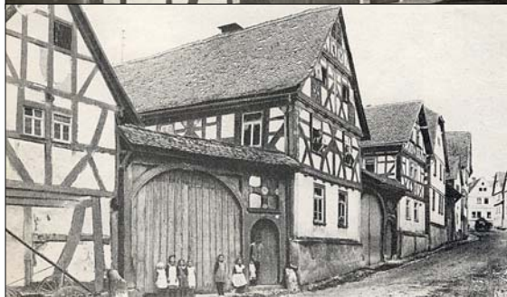
Bild 32 Fachwerkhaus Hauptstrasse 53 erbaut 1665, „Hirschwirts Haus“
