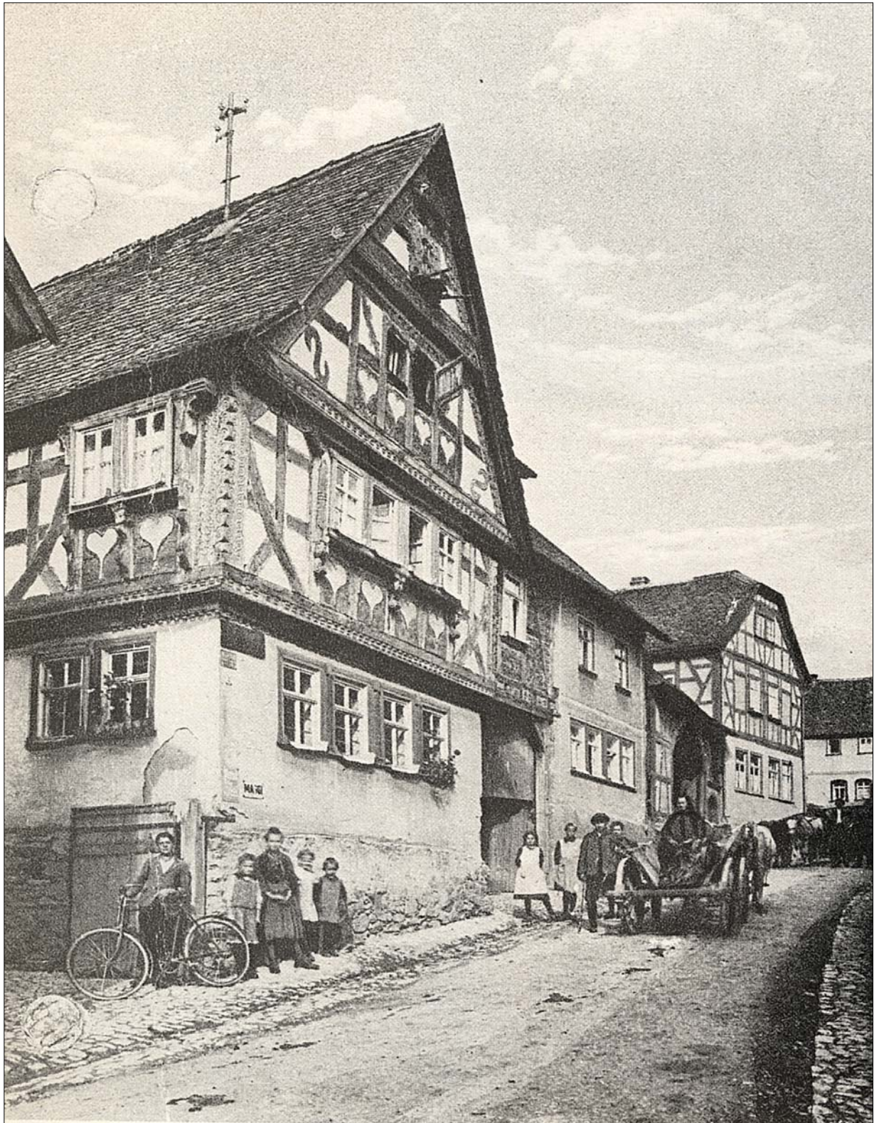
Bild 35 Fachwerkhaus Marienbergstrasse 3 (erbaut 1691)
